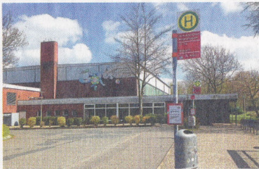
Die Halle der Gemeinschaftsschule ist gesperrt, nachdem eine Deckenplatte heruntergefallen war und vier Menschen verletzt hatte.
